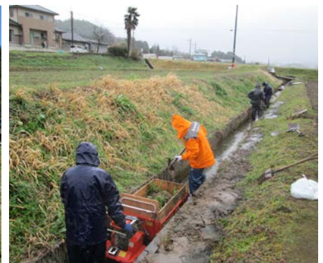
水路の土砂上げ(24年度)
