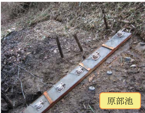
ため池栓の設置(24年度)
